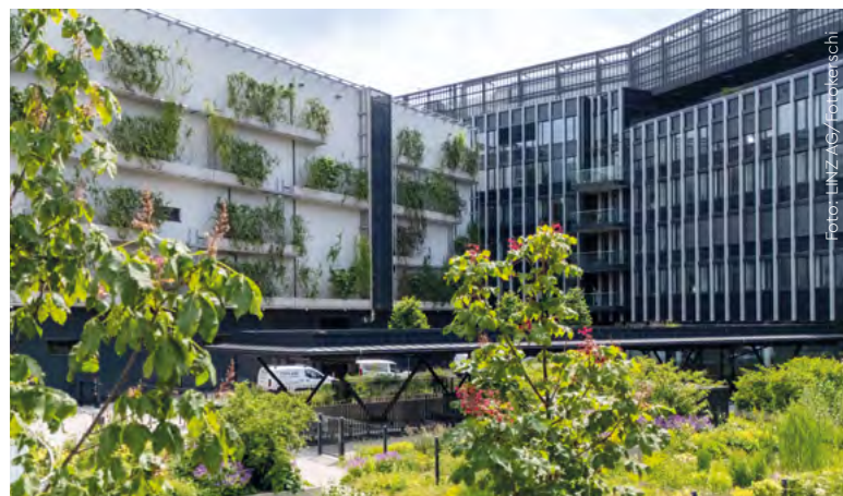
Das neue IT- und Data Center befindet sich im linken Teil des multifunktionalen Netzgebäude der LINZ NETZ GmbH (ein Tochterunternehmen der LINZ AG). Die bepflanzte Grün-Fassade ist ein sichtbares Beispiel für die Nachhaltigkeit des Rechenzentrums.
